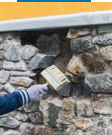
Увлажнение стены перед началом ремонт- ных работ
