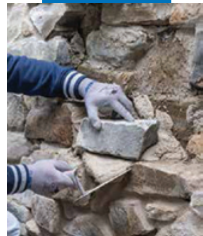
Укладка камней в необходимом месте
