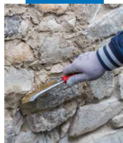
Нанесение финишного раствора металлической щеткой
