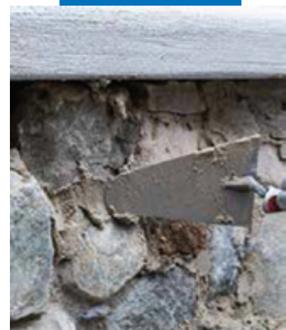
Выравнивание стены
